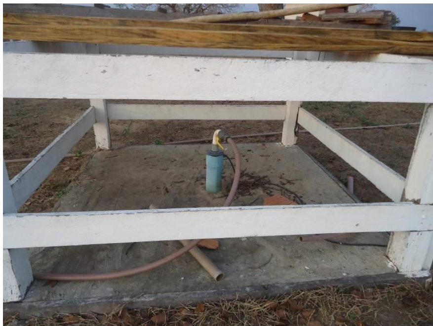
Figura 33 - Poço tubular utilizado para o abastecimento de água do Retiro.
