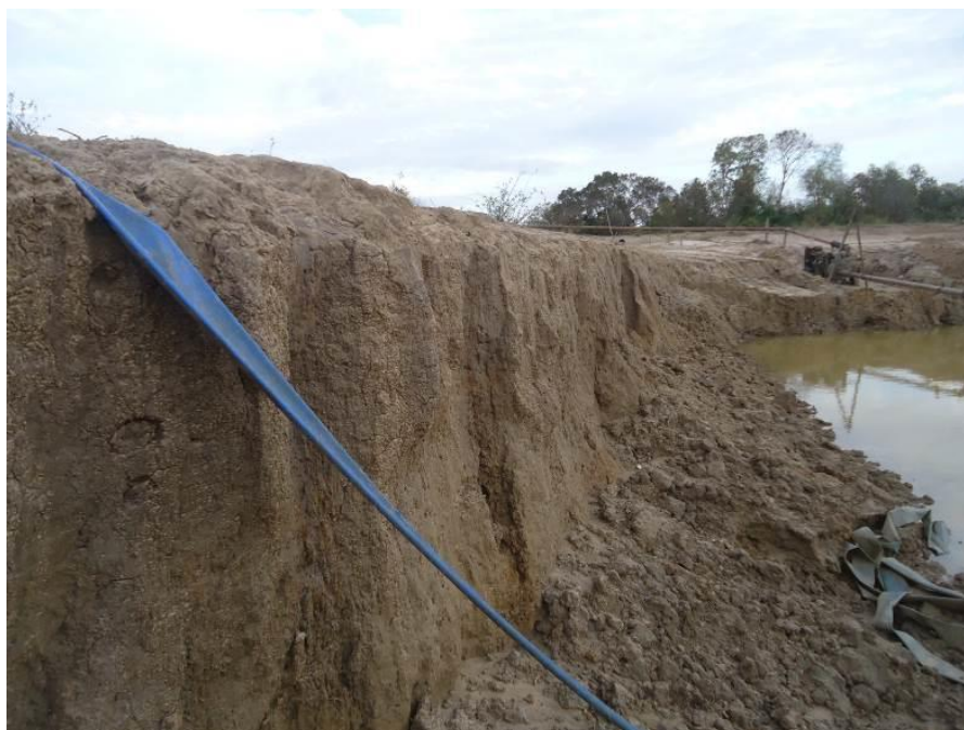
Figura 32 - Poço escavado com draga na região Norte da Fazenda Santa Maria. Observa-se um nível mais profundo da água.
