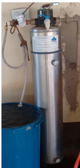
Figura 119 - Caixa da água com filtros
