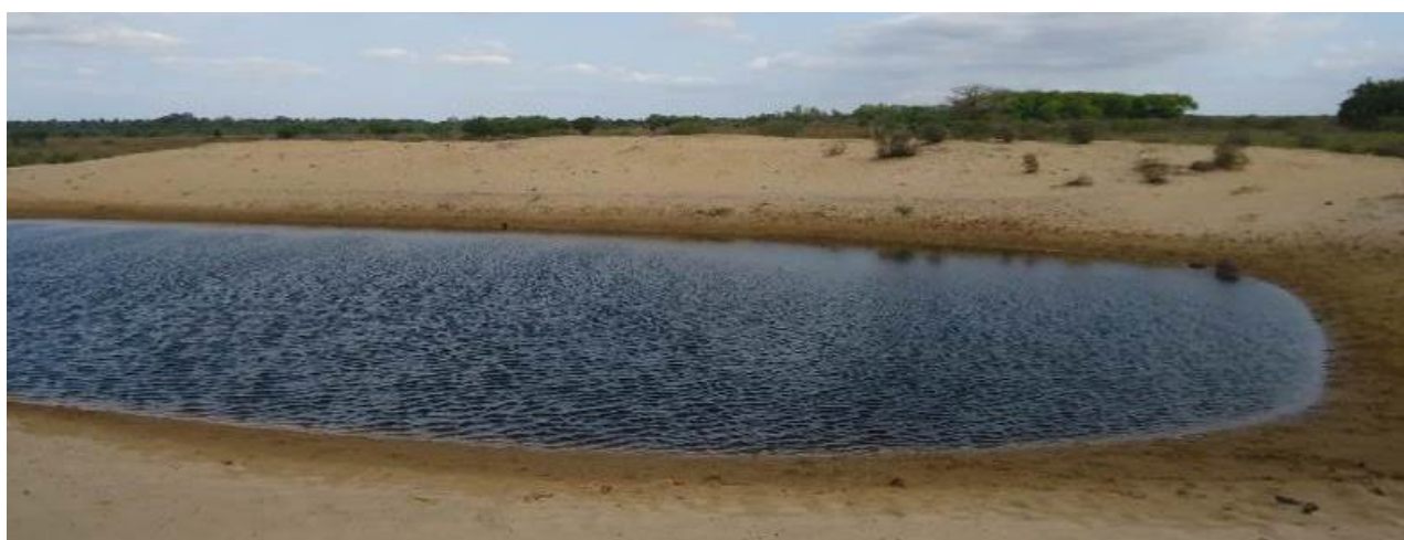
Figura 29 - Açude escavado para dessedentação animal.
