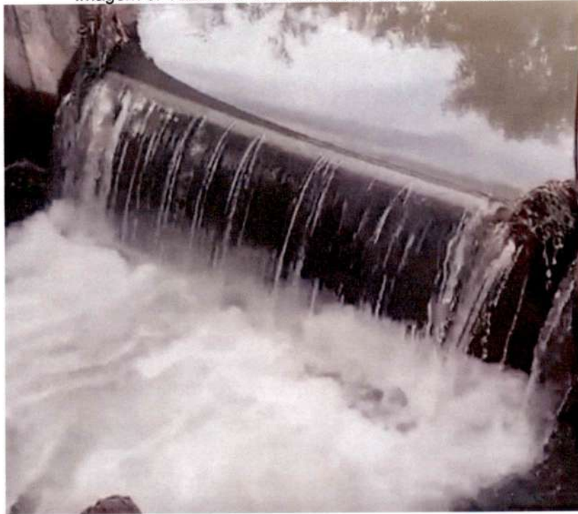
Imagem 6. Vazão no vertedouro da Cachoeira Vicenzi
