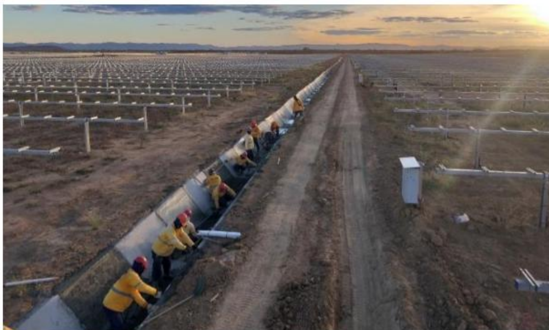
Construção de vala de drenagem em parque solar.
